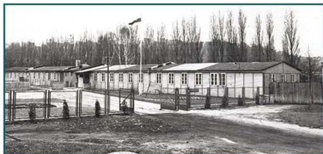
Pierwsza siedziba przy Al. Zjednoczenia w Gdyni / Archiwum OPEC
